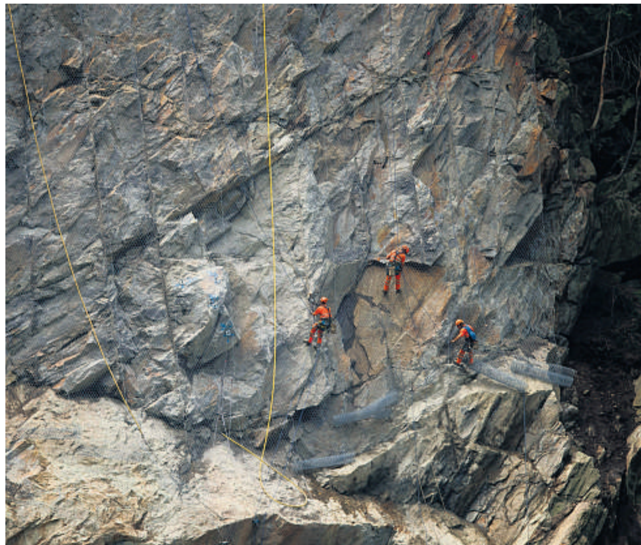
Arbeiter montieren Steinschlagnetze am gesprengten Felsen über der Bahnlinie bei Gurtellen.
