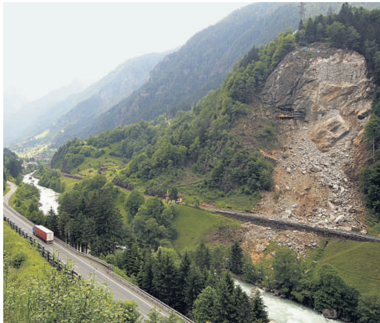
Blick auf die Kantonsstrasse und das Felssturzgebiet in Gurtellen nach der Sprengung vom 18. Juni.
