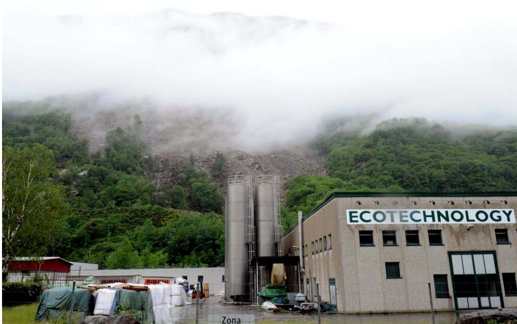
Evakuierung jederzeit möglich: Die Industriebetriebe, welche genau unter dem Felssturz liegen, nehmen ihren Betrieb wieder auf. (21. Mai 2012) Bild: Keystone
