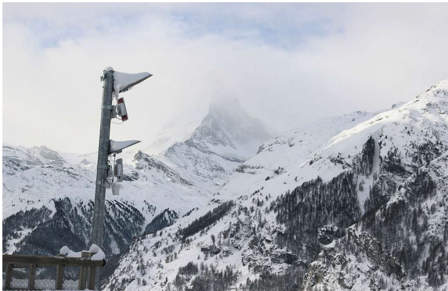
Die Radaranlage in Zermatt befindet sich auf 1800 Metern und überwacht den gegenüberliegenden Lawinenhang vor dem Eingang zum Dorf. (15. Januar 2016)
