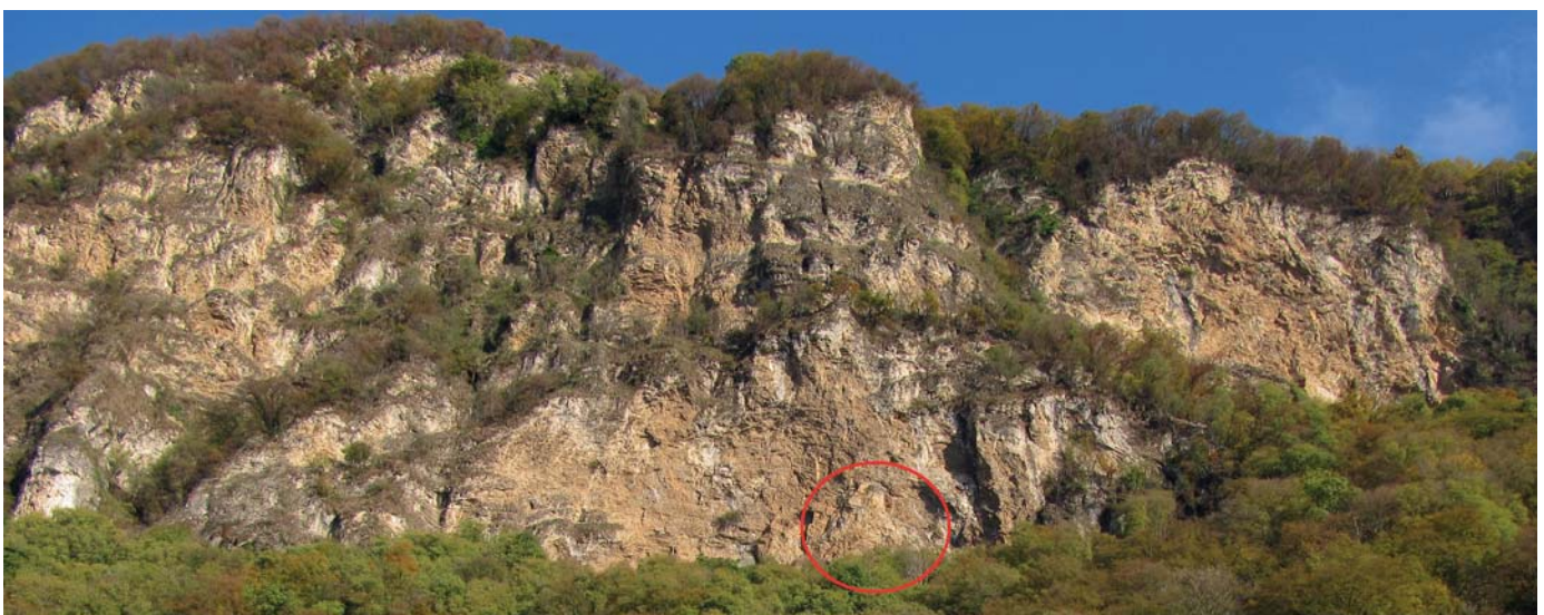
Bild 6. Felswand oberhalb von Mendrisio. Die zu überwachende Schuppe im unteren Wandbereich ist rot eingekreist.
