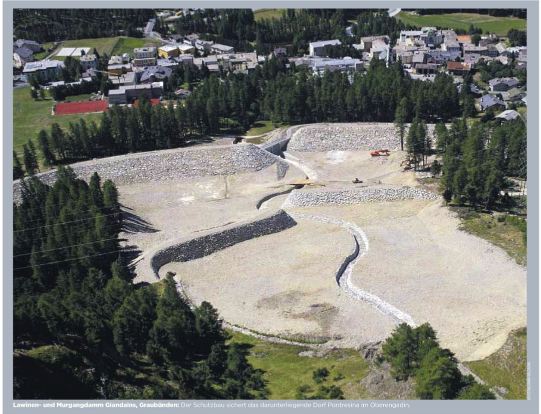
Lawinen- und Murgangdamm Glandains, Graubünden: Der Schutzbau sichert das darunterliegende Dorf Pontresina im Obereggadin.
