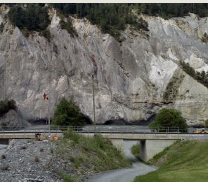
Mast mit Kamera auf der RhB Brücke.
