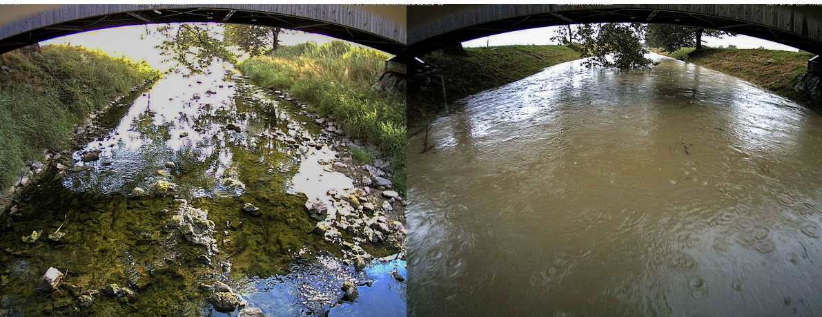
Titelbild: Hochwassereignis Rheintaler Binnenkanal.
