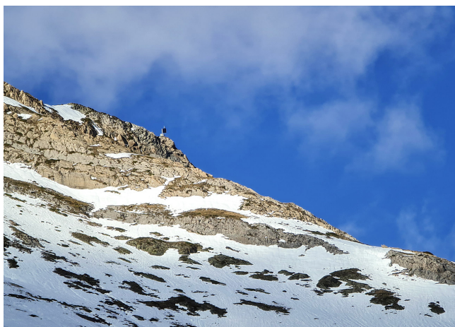
Abbildung 2: Die Lawinenradarstation befindet sich an einer exponierten Stelle am gegenüberliegenden Hang.
