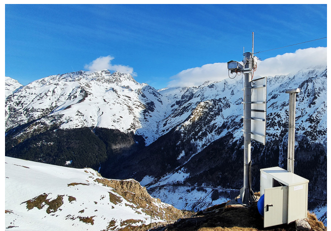
Abbildung 3: Das Lawinenradar ermöglicht die grossflächige Abdeckung der gegenüberliegenden Lawinenhänge mit nur einem Gerät.
