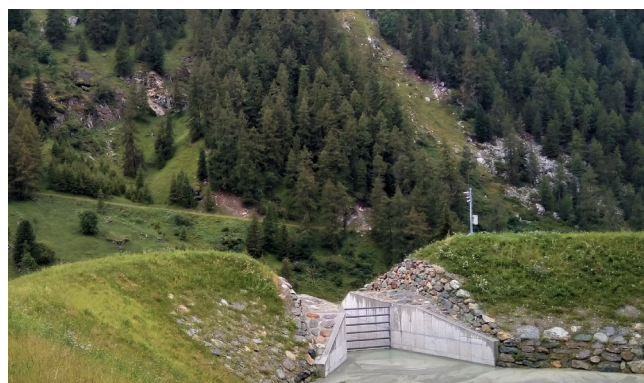
Abbildung 3: Das Personenradar bleibt ganzjährig installiert und wird zusammen mit dem Lawinenradar bei Winterbeginn jeweils wieder in Betrieb genommen.
