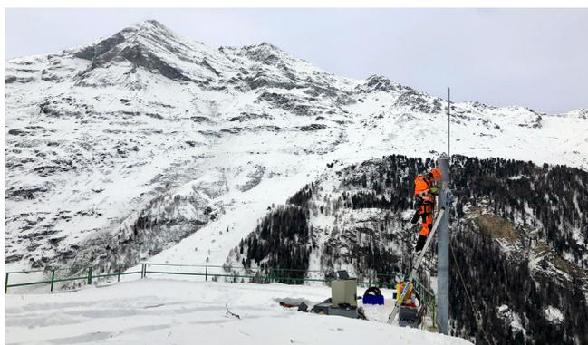
Figure 2 : L'équipe de Geoprevent installe le radar d'avalanche: en arrière-plan, les pentes à surveiller à la Garde de Bordons.
