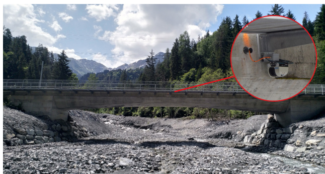
Abbildung 2: Die untere Station bei der RhB-Brücke: Der Laser vermisst den Brückenunterlauf des Carrerabaches.
