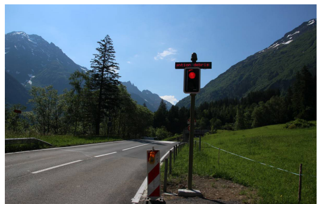
Abbildung 3: Automatische Strassensperrung mit Informationen für die Wartenden.
