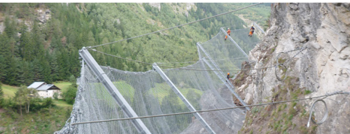
Titelbild: Sensoren oberhalb der Baustelle bei Ovella.
