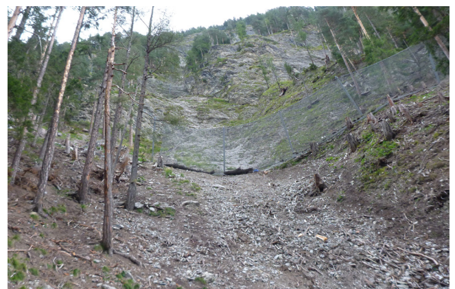
Abbildung 4: Die Baustelle wird hauptsächlich durch zwei Rinnen bedroht, die bis weit oben mit Schutznetzen gesichert werden mussten.
