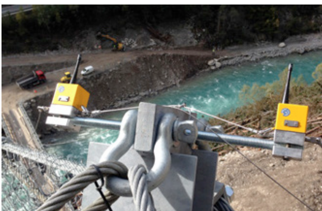
Abbildung 2: Mit je zwei Sollbruchstellen links und rechts kann jeder Sensor zwei Netzbereiche überwachen. 1.2 km überwachte Schutznetze schützen die Baustelle.
