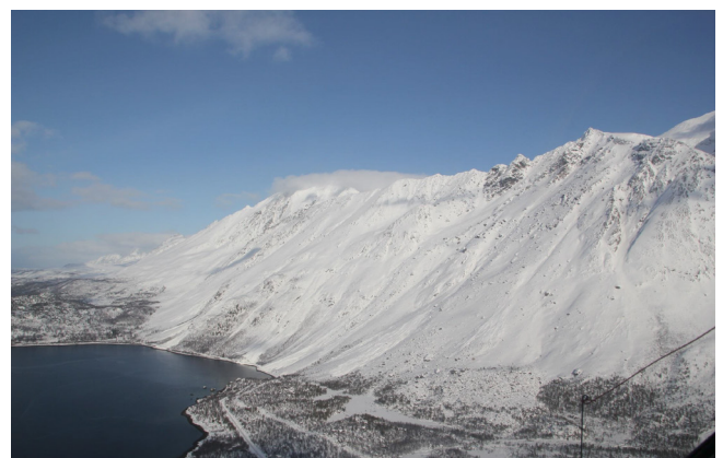
Abbildung 3: Die einzige Zufahrtsstrasse zu den am Meer gelegenen Dörfern befindet sich am Fusse des lawinengefährdeten Hangs (Bild: Statens Vegvesen).
