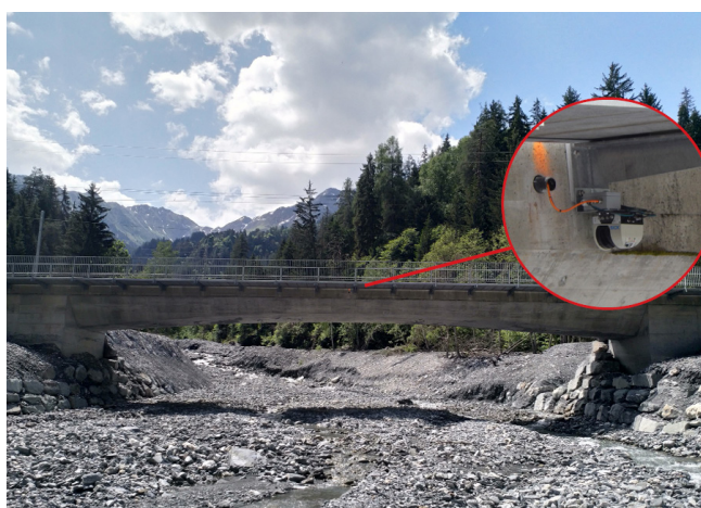
Figure 2 : Station située en aval près du pont des RhB avec un laser qui mesure le profil du ruisseau du Carrera.
