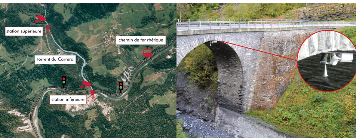
Image de titre : Le système d'alarme de Geoprevent surveille la ligne des Chemins de Fer Rhétiques au niveau de l'embouchure du Carrera dans le Rhin antérieur.
