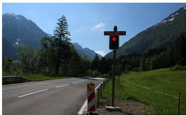
Figure 3 : Système d'alarme pour laves torrentielles: le texte défilant permet d'informer les usagers de la route bloquée aux feux.
