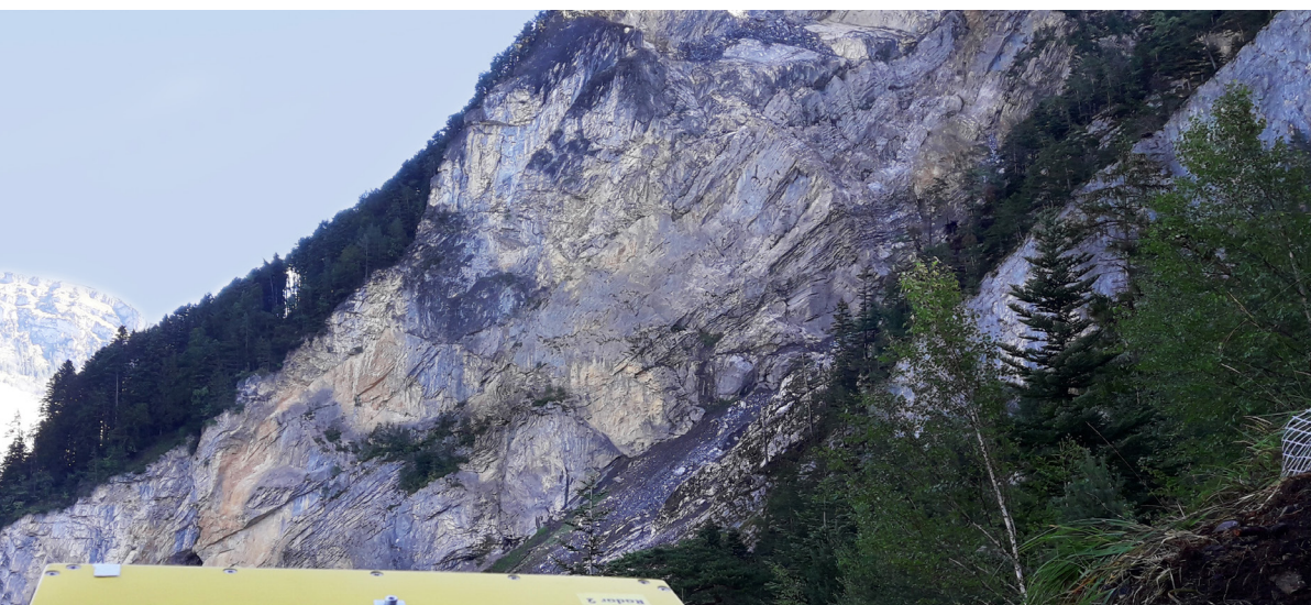
Figure 1 : Un géoradar interférométrique a scanné le site de rupture de l'éboulement de janvier 2019 du site de Plattwald.
