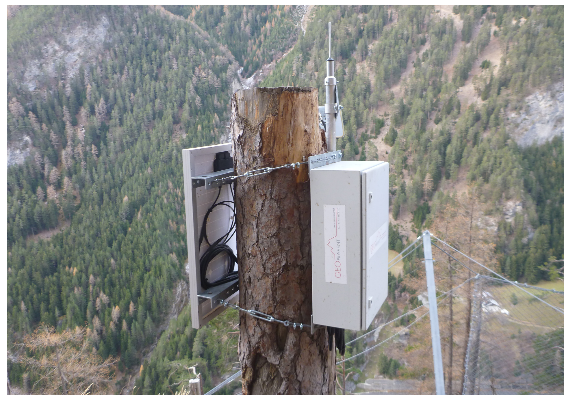
Die Relaisstationen im Hang sorgen dafür, dass die Signale aller Sensoren bei der Basisstation ankommen.
