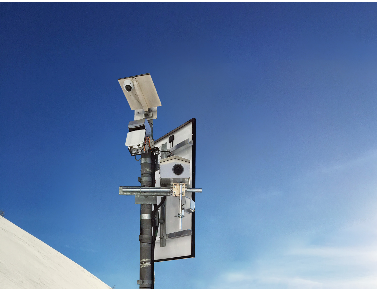
Radar d'avalanches en autarcie énergétique de Gonda, Suisse
