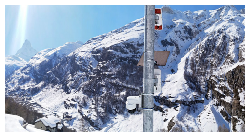
Radar d'avalanches avec fermeture de route automatique
